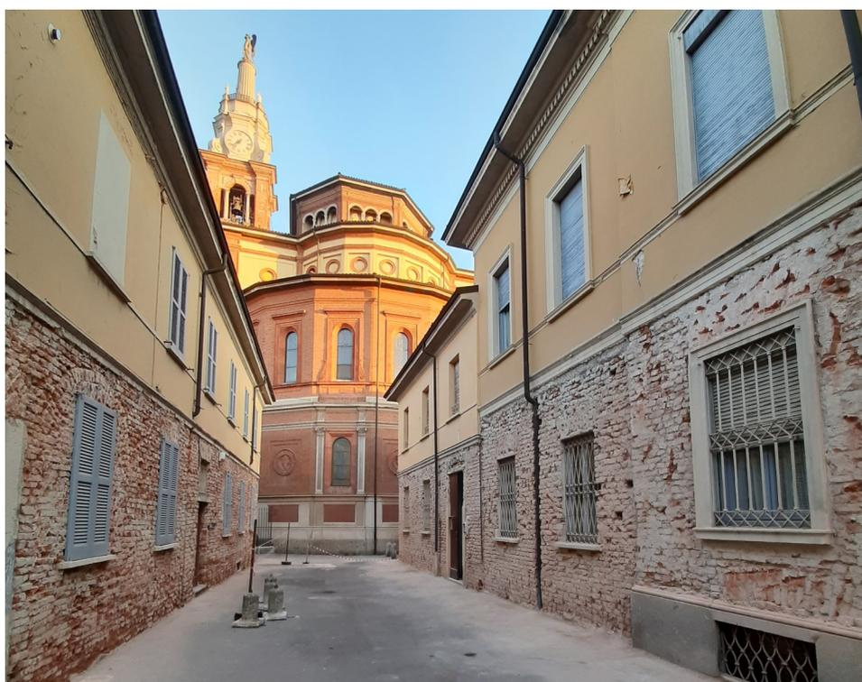
Le foto in alto mostrano con chiarezza la necessità del rifacimento delle facciate in via Mons. Rizzi. Come si vede dalla foto sopra, l'intonaco ammalorato è stato rimosso. Esso verrà sostituito da un nuovo intonaco con caratteristiche approvate dalla Soprintendenza.
